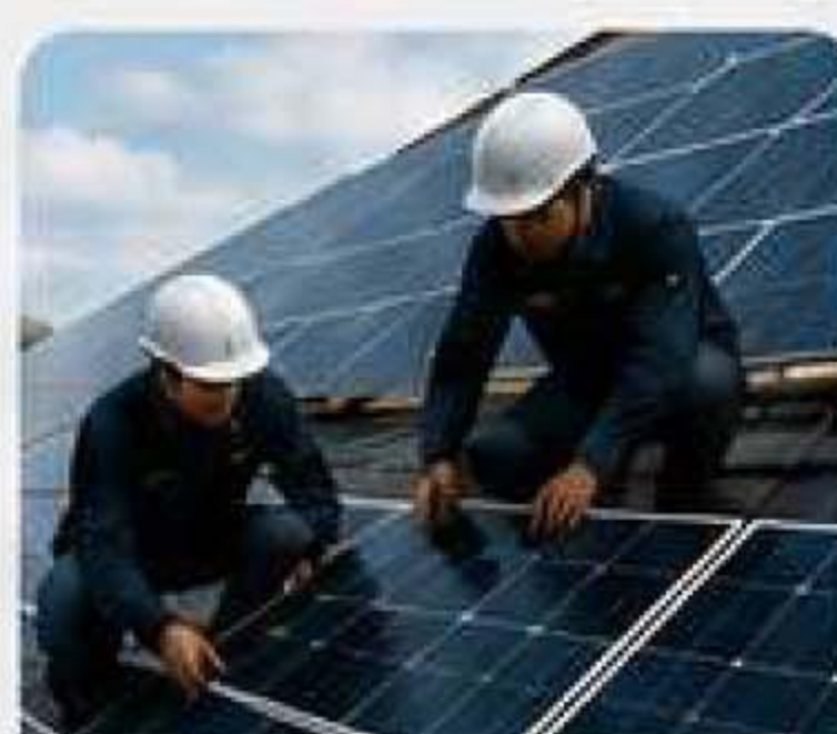
INSTALASI (Pemasangan Profesional)
